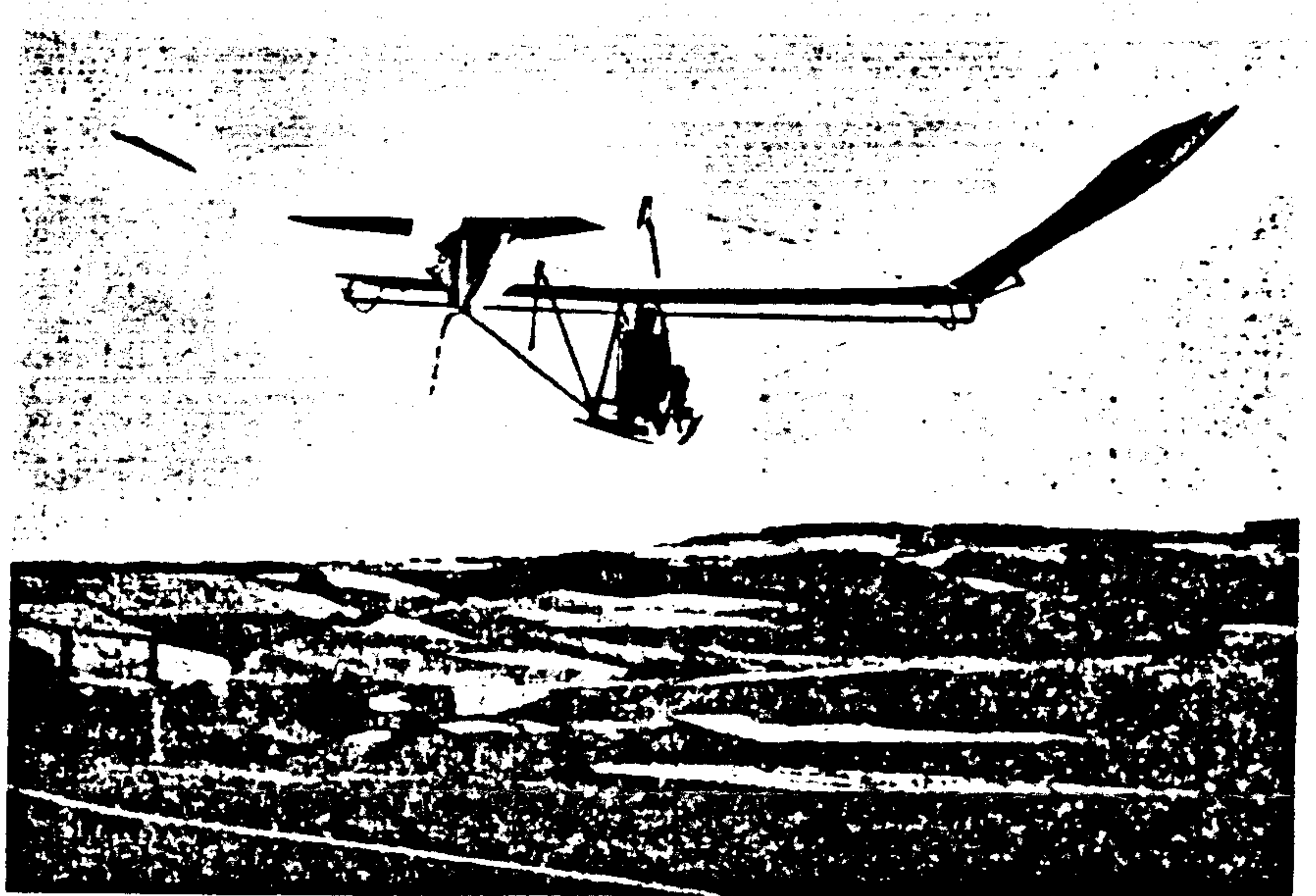
Das Bild zeigt eine Versuchsanordnung eines Schwingenflugzeugs. Durch das Kriegsende konnte Arno Vogel seine Arbeiten leider nicht fortsetzen. In den nächsten Heften wird über diese Arbeiten noch eingehender berichtet.
